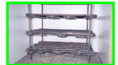
Armatures du bossage inférieur
