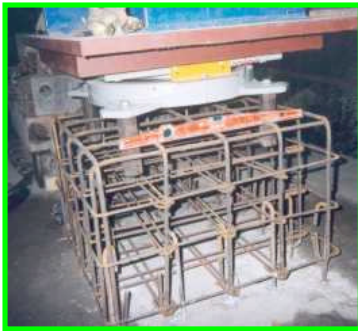
Armatures du bossage inférieur
