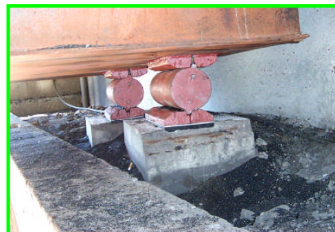
Appuis mobiles restaurés
