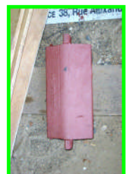
Embase inférieure d'appui fixe avant remontage
