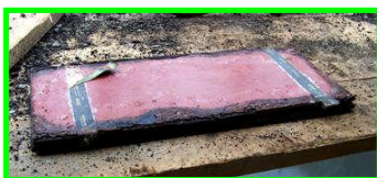
Ancien appui déposé
