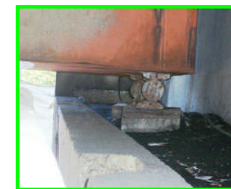
Appuis mobiles après sablage sur site et avant vérinage et démontage
