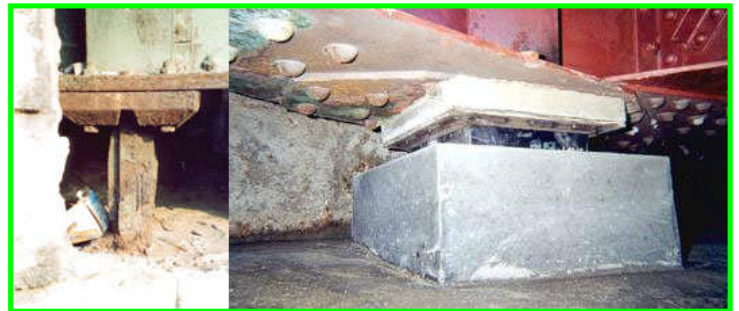
Echangeur A- / A10 à Wisous (91) Remplacement des balanciers métalliques
