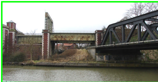
Pont rail sur le canal et ponts canaux de l'ascenseur
