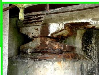
Appuis métalliques mobile et fixe entièrement bloqué
