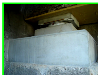
Nouveaux appuis à pot sur bossages en micro-béton
