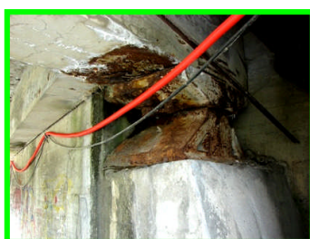
Appuis métalliques mobile et fixe entièrement bloqué
