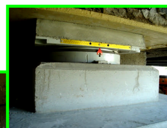
Nouveaux appuis à pot sur bossages en micro-béton
