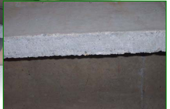
Aspect de la nervure après ponçage (disparition de la laitance superficielle)
