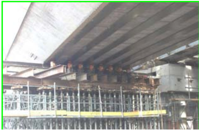
Vérins 105 tonnes en place sur la palée de la pile pour vérinage et mise en place des patins
