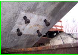
Contre-platine en inox posée avant bétonnage.
