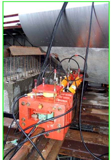
Sabot hydraulique avec verin pousseur
