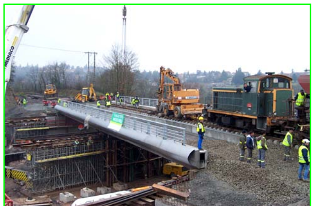
Les tabliers sont en place, travaux de voies en cours
