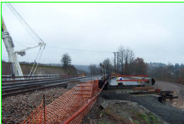
Vue sur un tablier avant ripage
