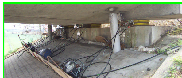
Passage supérieur : Vue sur une pile et une culée en cours de vérinage
