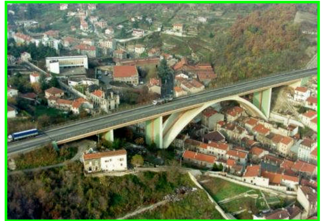
Autoroute A47 – Département de la Loire (42) Viaduc de Rive de Gier
