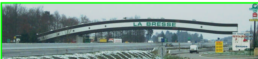
Autoroute A40 - Passerelle piétonne A Bourg en Bresse (01)
