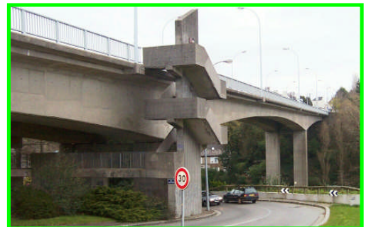
Viaduc du Forestou Ville de BREST (29)
