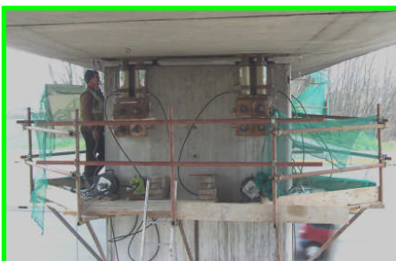
Passage supérieur : Vue sur une pile et une culée en cours de vérinage
